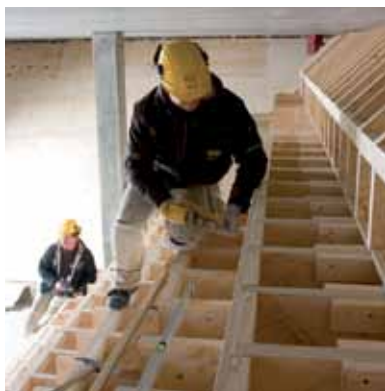
Byggeri af det nyskabende Fælleshus for Herstedlund
